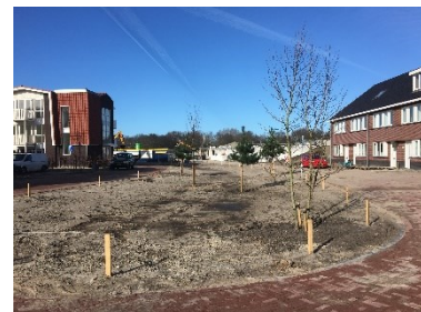
Figuur 3 Wadi in aanleg (Varne Buiten)
