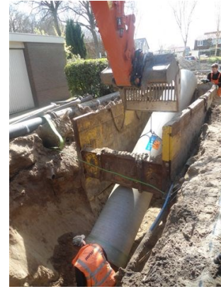
Figuur 4 Riolvervanging Holleweg
